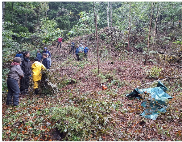
Abb. 14: Ende September 2025 ist die Schulklasse Surbtal im PC 74 Grünholz mit Freiräumungsarbeiten beschäftigt.
